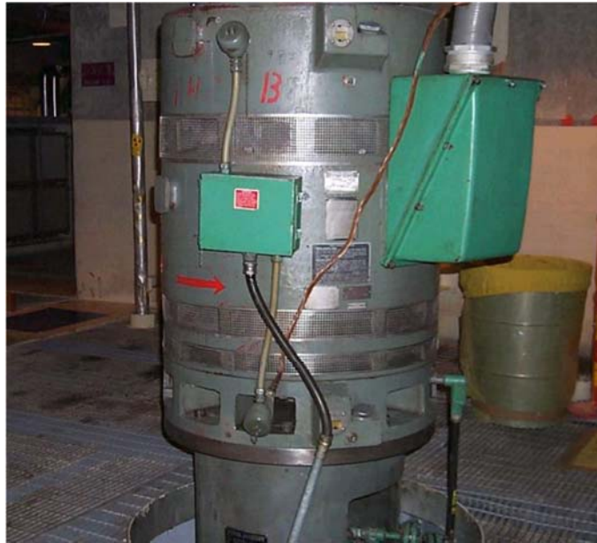
餘熱排除系統(RHR B)泵
