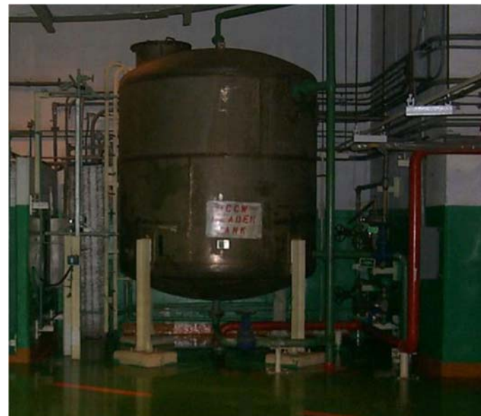
核機冷卻水系統 (NCCW) 調節槽
