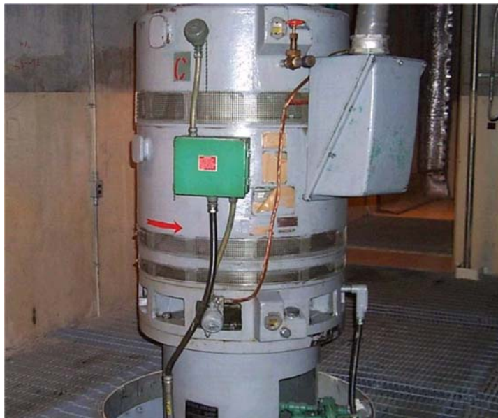
餘熱排除系統(RHR C)泵
