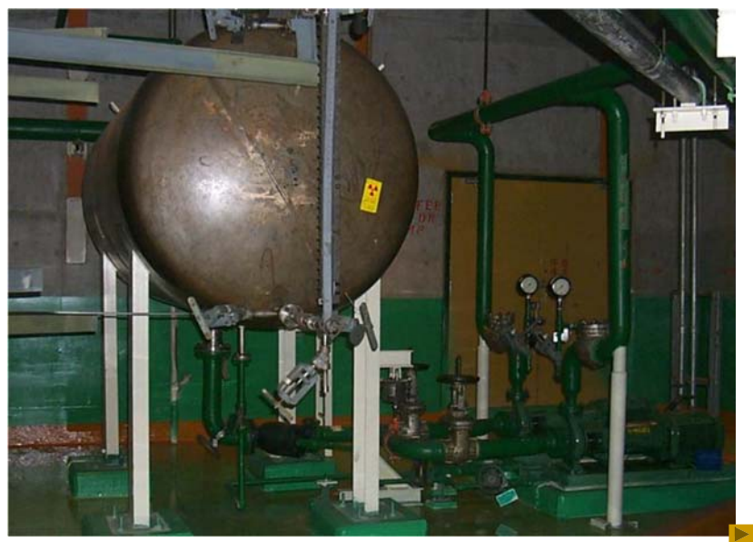
斜管燃料傳送系統 (IFTS) 洩水槽
