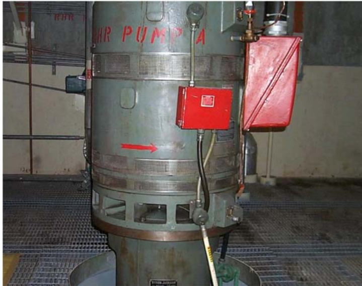
餘熱排除系統(RHR A)泵
