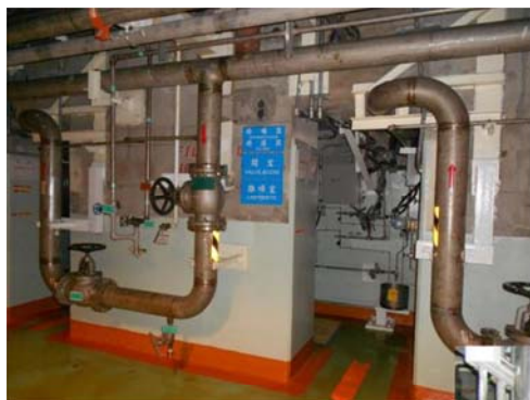
南側-廢水處理設備 圖示為除礦器過濾器
