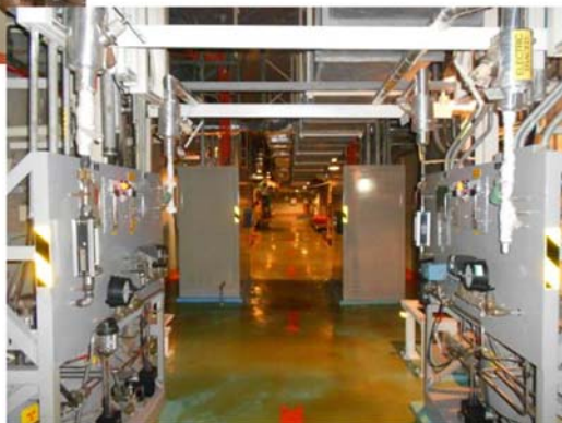
北側-廢氣處理設備 圖示為POST-TREAT R.M.
